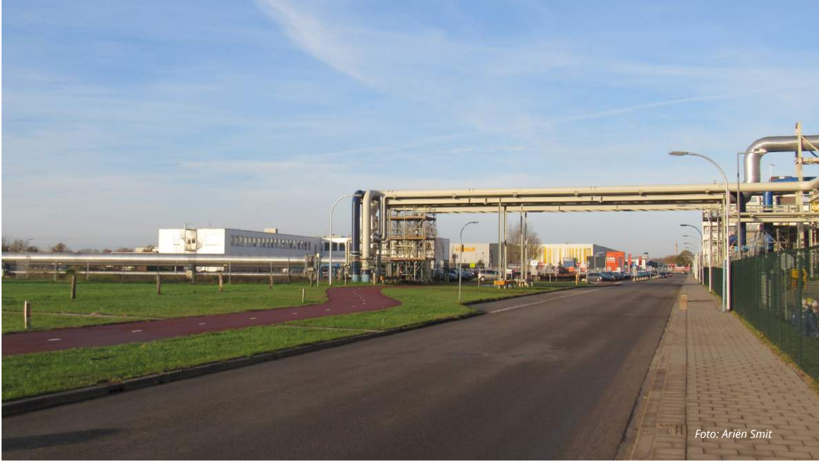
Op het High Tech Systems Park (HTSP) in Hengelo gebruikt Nouryon restwarmte uit de nabijgelegen Bio Energie Centrale van Twence. De restwarmte van Nouryon wordt weer door andere bedrijven gebruikt. Daarnaast is een bronnet gerealiseerd om ook in duurzame koude te kunnen voorzien.
